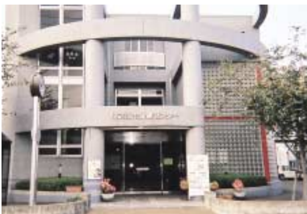
川之江市保健センター
